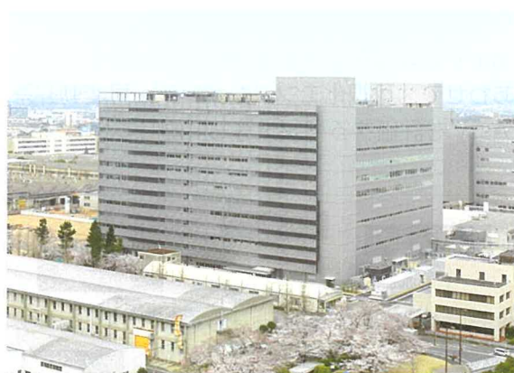
図2 パワートレーン共同開発棟全景
